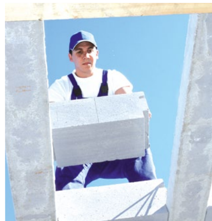
Ukládání stropních vložek
