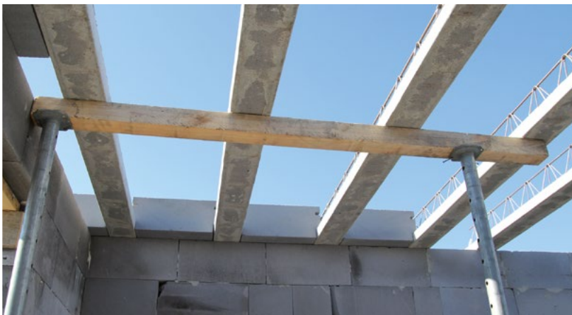
Podpěření stropních nosníků
