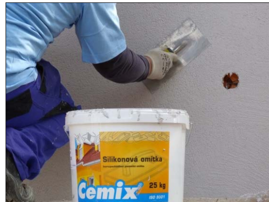
Obr. 6: Natahování strukturální omítky
