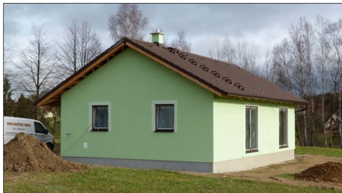
Obr. 7: Hotová fasáda objektu
