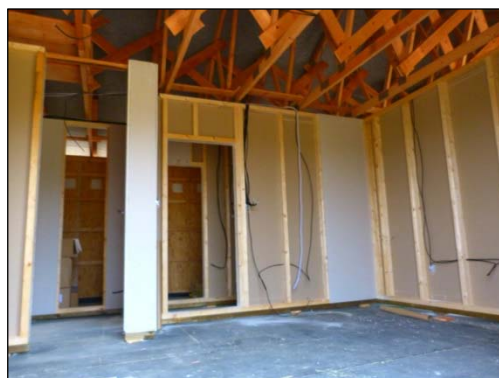
Obr. 3 Vnitřní konstrukce dřevostavby
