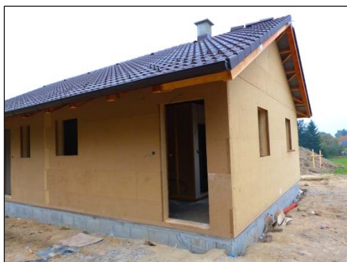
Obr. 2: Příklad opláštění dřevostavby dřevovláknitými deskami
