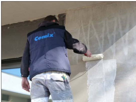
Obr. 5: Provádění penetračního nátěru omítky
