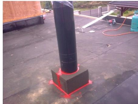
**4. POZOR!** Je třeba **zabránit vnikání vody** do tělesa prostupu (např. odkapávající námraza ze střešní krytiny). Při použití prostupu tam, kde hrozí zatečení vody do prostupu a její následné zmrznutí, je nutno povrch prostupu ošetřit tak, aby k zatečení vody dojít nemohlo. To je možno provést např. překrytím plochy prostupu vrstvou tepelně odolného tmelu.
