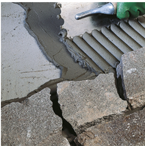
Lepení klinkeru v eteriéru
