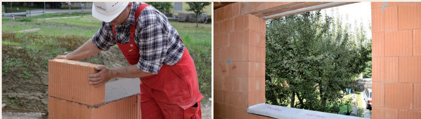
7.7.1 Pro optimální vytvoření ostění stavebních otvorů jsou k dispozici poloviční cihly.
