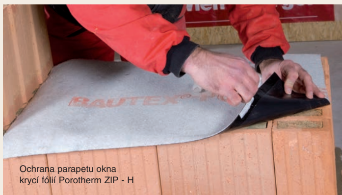
7.13.2 Zakrytí musí být ochráněno proti účinkům větru.
