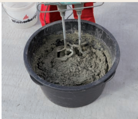
7.1.5 Zakládací malta Porotherm Profi AM (případně zimní malta s označením W) se namíchá dle pokynů výrobce uvedených na obalu.
