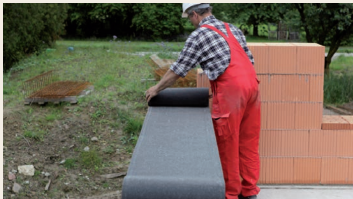
7.13.1 Po ukončení práce zakrýt všechny koruny zdí.
