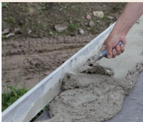
7.1.6 Malta se rozprostře zednickou lžící.
