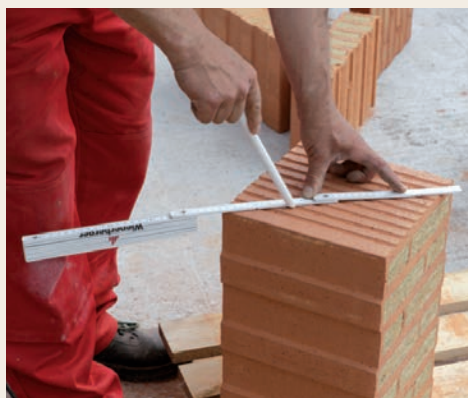
7.8.5 Řezy se naznačují jak pro pilu pro mokré řezání, tak i pro ruční pilu.
