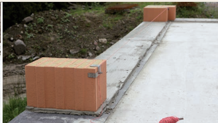
7.2.2 Se zděním obvodových stěn se začíná v rozích osazením rohových cihel. K nim se přikládá vodící šňůra.
