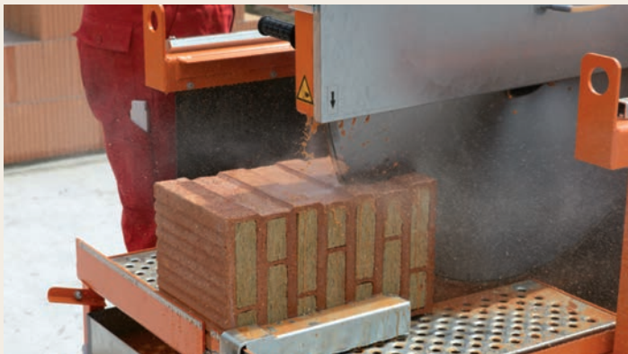
7.5.1 Výškové vyrovnání: cihlu rozříznout pilou na mokré řezání.
