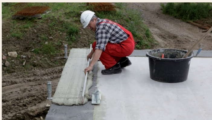
7.1.7 Malta se urovná stahovací latí na vodících lištách vyrovnávací soupravy.
