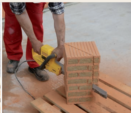
7.8.6 Suché řezání elektrickou ruční pilou.
