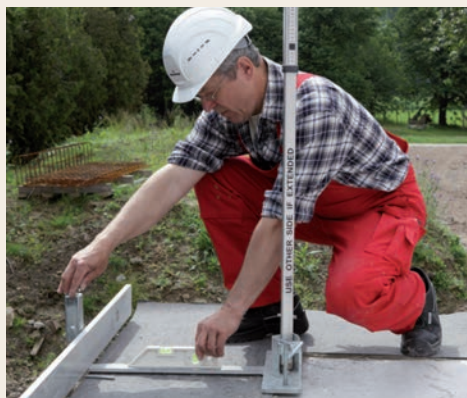
7.1.4 Pro přesné výškové uložení zakládací malty se používá vyrovnávací souprava (viz program produktů Wienerberger).
