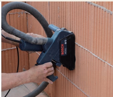
7.11.2 ... svislé drážkování pro elektrické rozvody.
