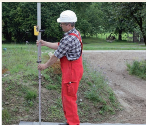
7.1.3 Aby bylo možné stanovit minimální výšku vrstvy malty, zjišťuje se nejvyšší bod betonové desky pomocí nivelačního přístroje nebo hadicové vodováhy.
