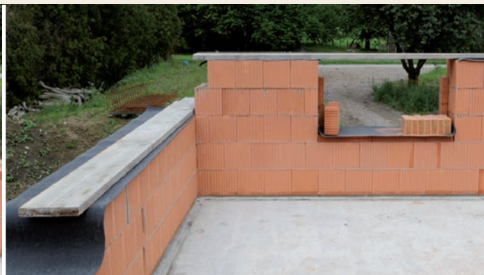
7.13.2 Zakrytí musí být ochráněno proti účinkům větru.
