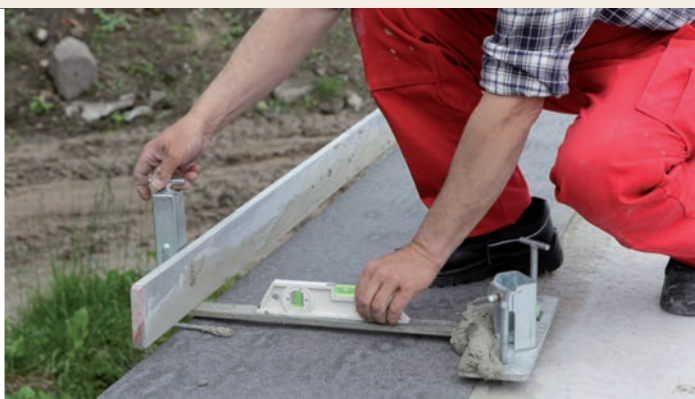
7.1.8 Poté se jeden přípravek vyrovnávací soupravy přesune o délku stahovací latě a znovu vyrovná.
