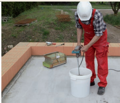
7.3.2 Tenkovrstvou maltu smíchat s vodou a rozmíchat podle návodu uvedeného na pytlí s maltou pro tenké spáry.
