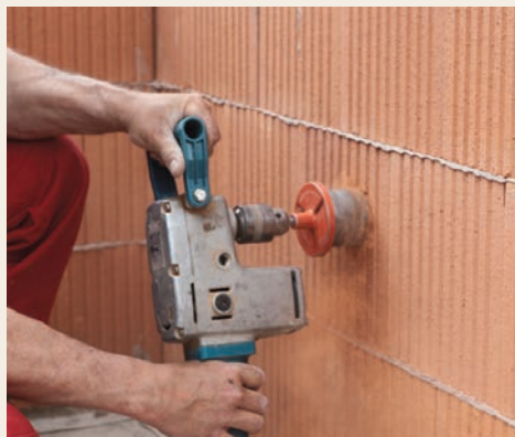
7.11.1 Vrtání kruhovým děrovačem a ...
