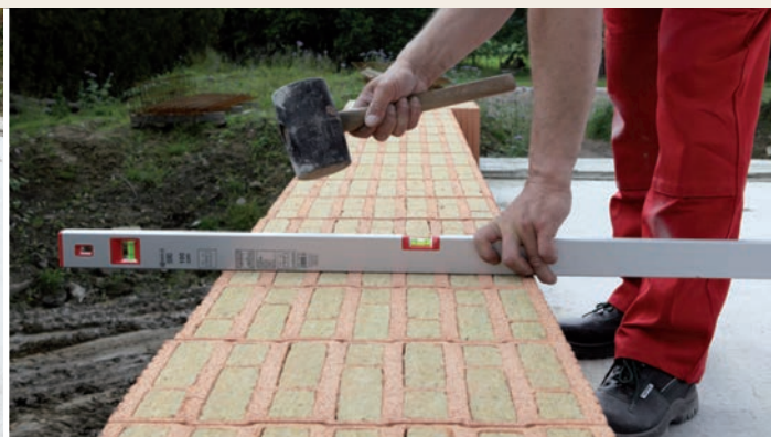
7.2.4 Cihly se nakonec urovňají v obou směrech pomocí gumové paličky a vodováhy.
