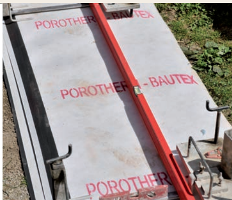
7.1.2 Proti vztlínání vlhkosti se pokládá v místě budoucí vyzdivky hydroizolační fólie (např. Porotherm ZIP - S).
